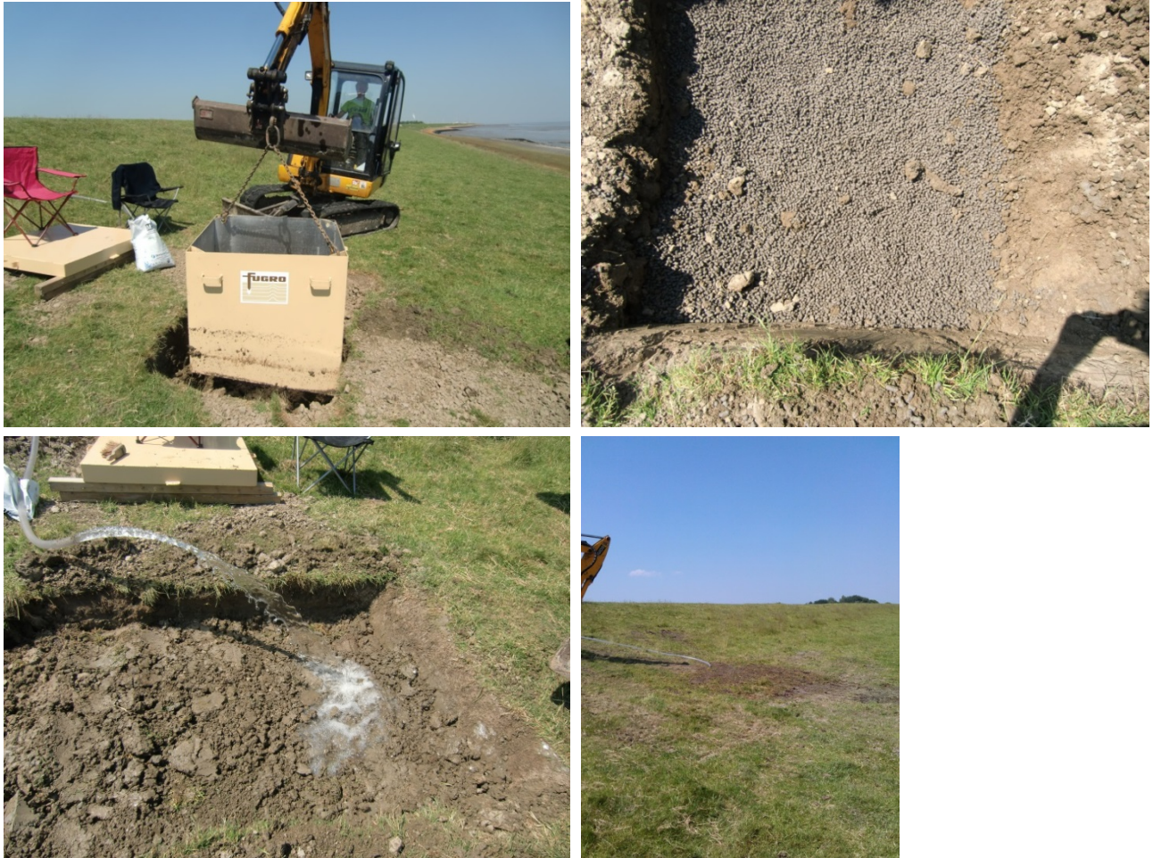
Figuur 8: Demobilisatie van de proefopstelling en het aanhelen van de deklaag
