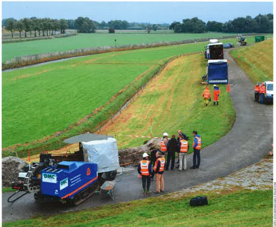
Aanbrengen van het Dijk Monitoring- en Conditioneringssysteem in de Ommelanderzeedijk, september 2012.
